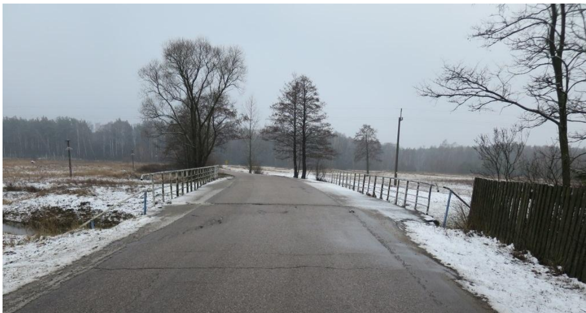
Rys. 1.2 Widok obiektu w terenie
